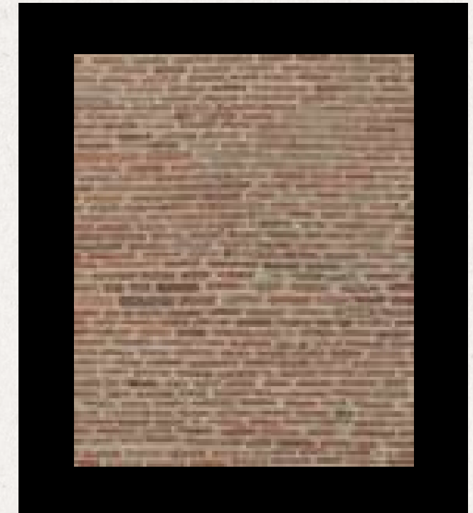
MUR EN BRIQUE
